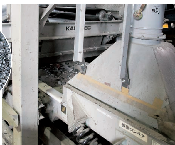
破砕された家電は磁力選別機で鉄を回収
