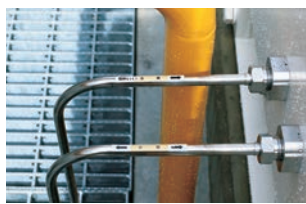
現地配管採用部位
