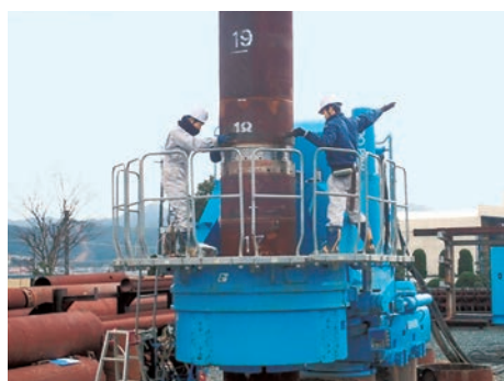
施工試験状況
