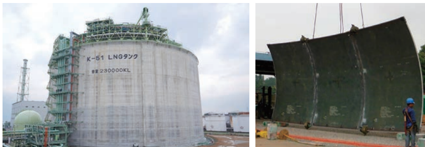
世界最大規模の大阪ガス(株)泉北製造所第一工場5号タンク
