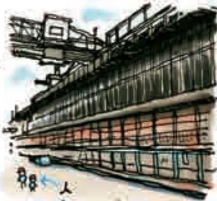
高213m(炉高6m)、奥行き16m、全長600mで格子戸のような構造
