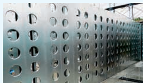
高強度のスチール壁(大分製鉄所明野北社宅の建設現場)
