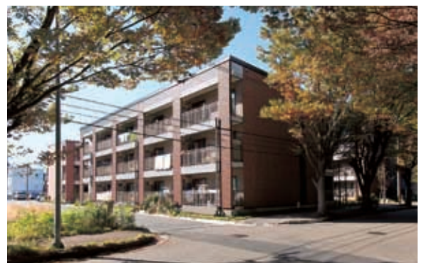
釜石市上中島町復興公営住宅(第Ⅰ期) 薄板軽量形鋼造(NS スーパーフレーム® 工法)3階建て
