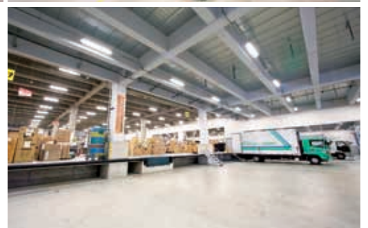
大型トラックが直接乗り入れ、フォークリフトが往来し、 1.5t/m 2 の大荷重に耐え得る大空間を実現
