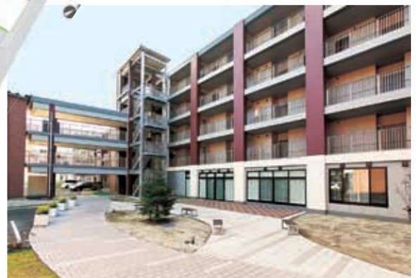
釜石市上中島町復興公営住宅(第Ⅱ期)鉄骨造5階建て
