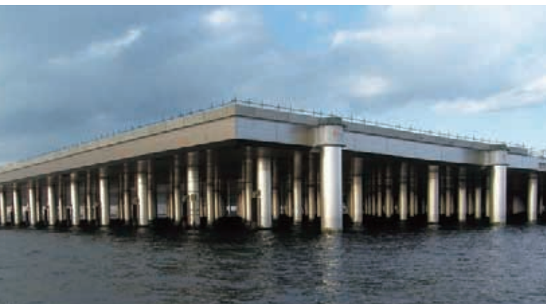
羽田空港D滑走路橋脚
