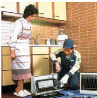
都市ガス原料の天然ガスへの切り替えに伴って、1972(昭和47)年からガス器具の調整を行う熱量変更作業が進められた。
