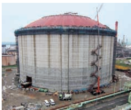
7%ニッケル鋼板を採用した大阪ガス(株)泉北製造所第一工場5号タンク、右写真はタンク内部(大阪府堺市)
