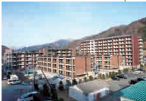
釜石市上中島町復興公営住宅第Ⅱ期
