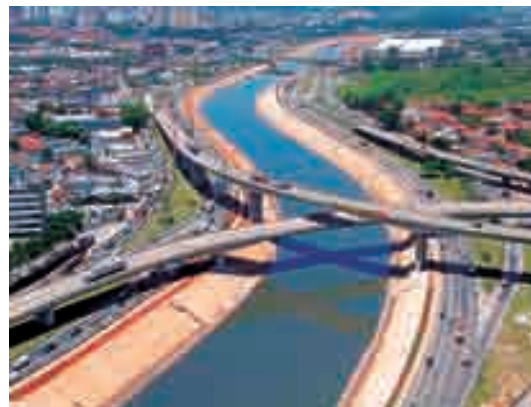
改修されたチエテ川 © JICA 日本とブラジルをつなぐ友好のシンボルの一つとなった。
