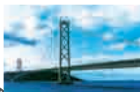
明石海峡大橋
