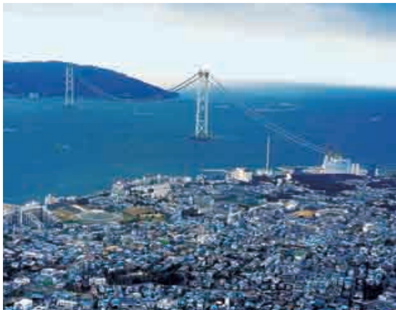
阪神・淡路大震災後まもなくの神戸市と建設中の明石海峡大橋
