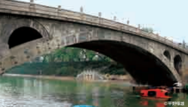
ちょうしゅう 趙州橋
