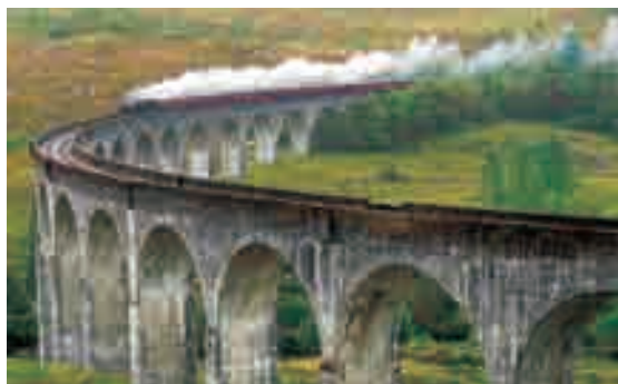
グレンフィナン高架橋 (イギリス) 長さ 380 m、高さ 30 m、21 個のアーチからなる。1901 年に建設され、鉄筋コンクリートの高架橋としては世界最古と言われる。
