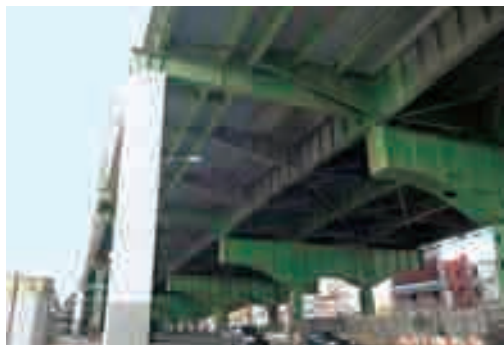
ニューヨークの鋼製高架橋
