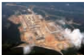
TKUS全景。TKUSは米国南部アラバマ州にある熱延・冷延・溶融亜鉛めっき製品の製造拠点
