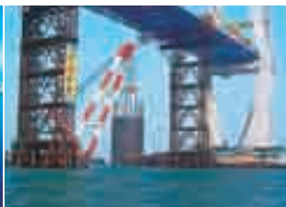
仁川大橋(韓国) 鋼矢板セル式船舶衝突防止施設 (使用イメージ写真提供: サムスン建設)
