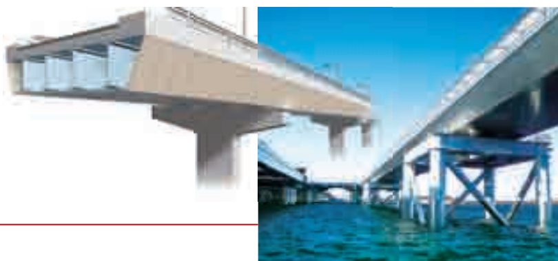
羽田空港D滑走路連絡橋(東京都)
