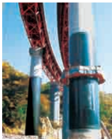
トウシート®工法による橋脚の補強例
