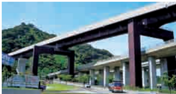
北陸新幹線北陸道架道橋(新潟県)
