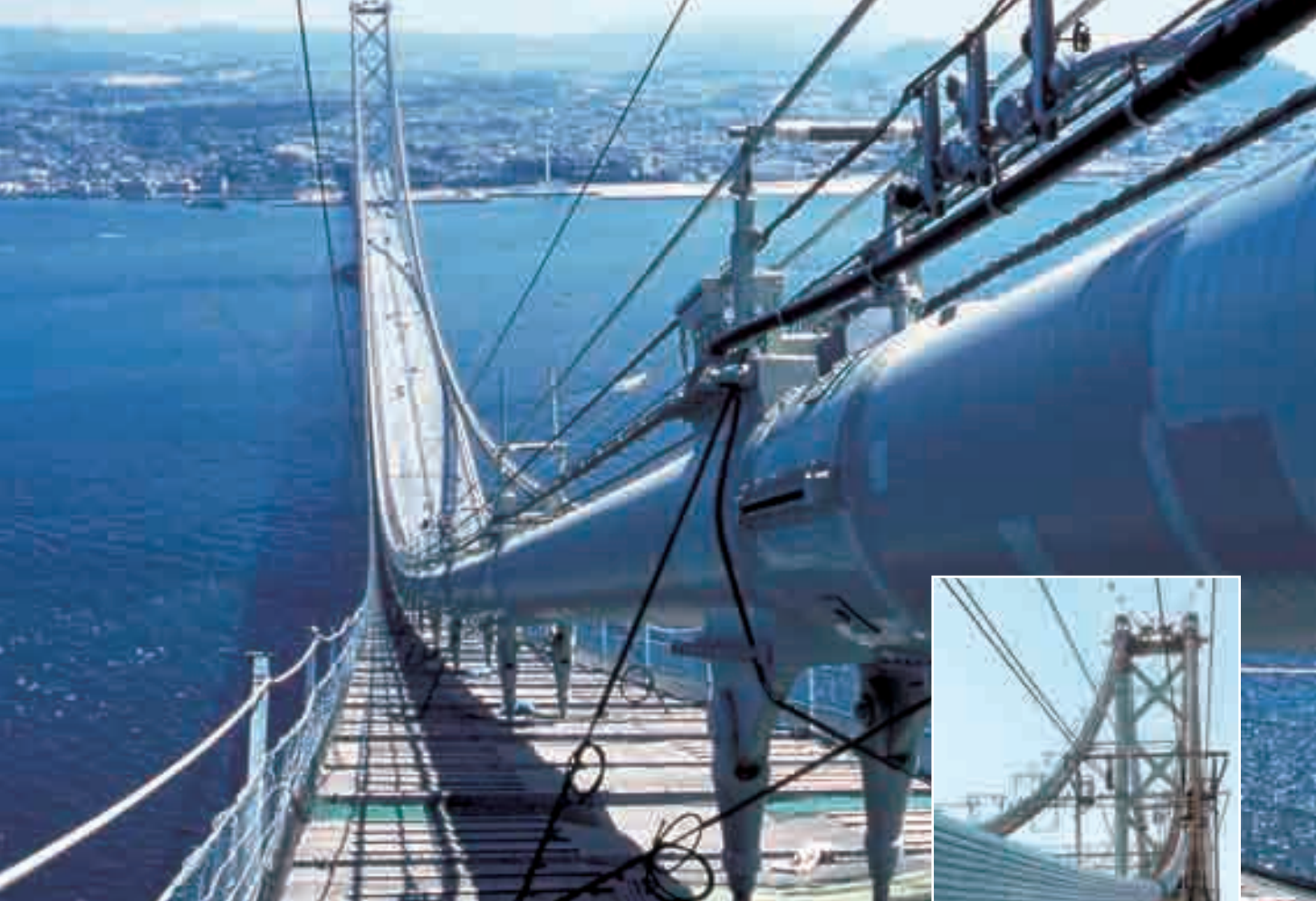
ケーブルの架設
