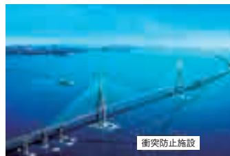
仁川大橋(韓国) 鋼矢板セル式船舶衝突防止施設 (使用イメージ写真提供: サムスン建設)
