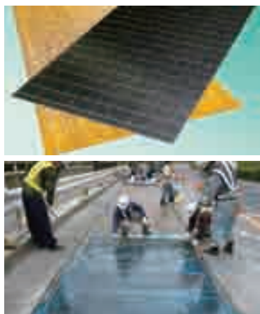
Strandシート®(上)と橋梁床版の補修例
