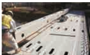
狹隘地での施工例(第二左越橋(新潟県))
