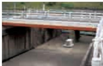
下部工を再利用した架け替え例(熊西跨道橋(福岡県))
