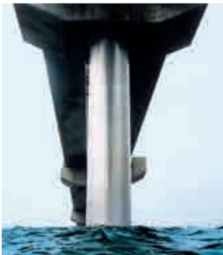
非常に高い耐食性・耐久性を持つチタン板やステンレス鋼板で鋼材の表面を保護するのが、金属被覆工法だ。東京湾横断道路や羽田空港D滑走路連絡橋の橋脚に採用され、50年以上の防食寿命ニーズに答えている。
