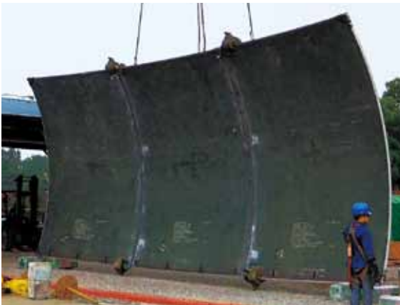
建設中の大阪ガス(株)泉北第1工場5号タンク(堺市)に採用された7%ニッケル鋼板。内容量23万m 3 の世界最大級のLNGタンクで、同製品を約3,800トン使用
