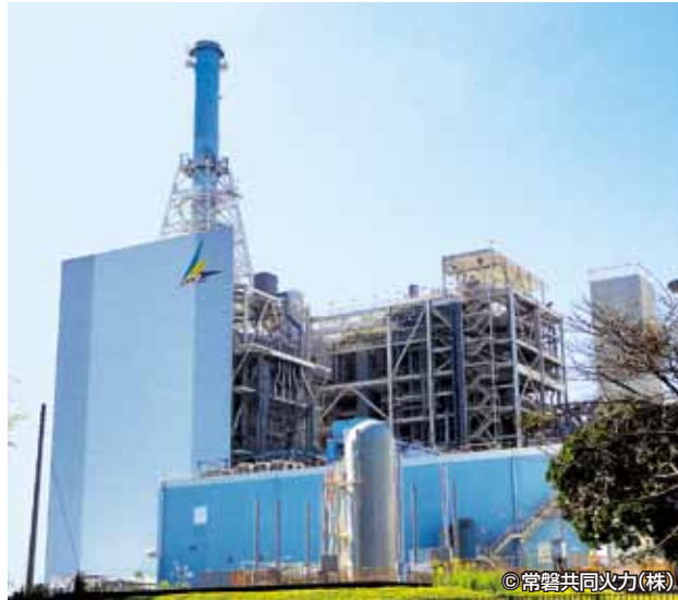
勿来発電所(福島県いわき市)で行われたIGCCの実証試験に当社の厚板が適用された。実証機は現在、商用設備として運転中。
