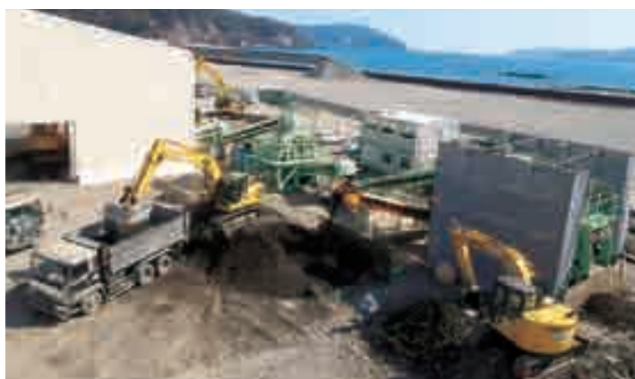
カルスピン®工法を活用した再生処理の全景
