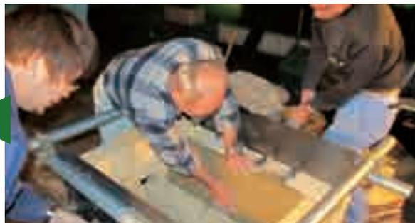
耐火レンガを積み上げて、たたら炉を築く
