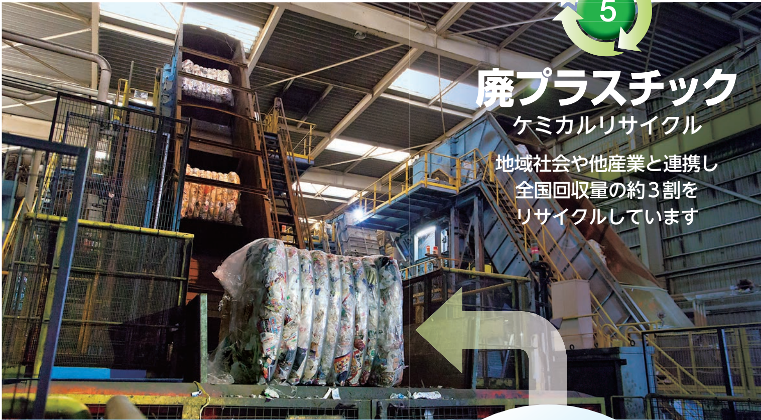
君津製鉄所のプラスチックリサイクル設備
