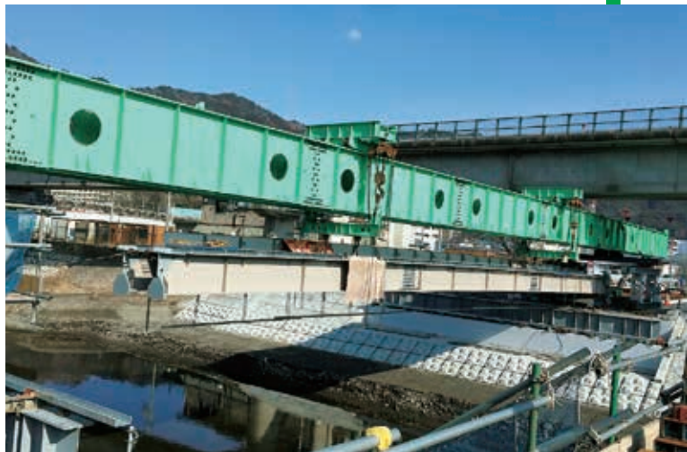
施工当時の千年橋（岩手県金石市）
