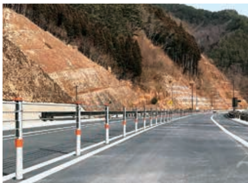
三陸沿岸道路両石地区(岩手県釜石市)
