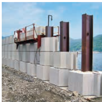
釜石港大平地区 (岩手県釜石市)
