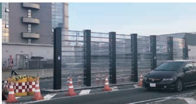
白鳥地区津波防御施設整備事業（宮城県仙台市）
