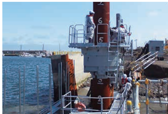
仙台塩釜港仙台区向洋地区岸壁耐震改良工事(宮城県仙台市)
