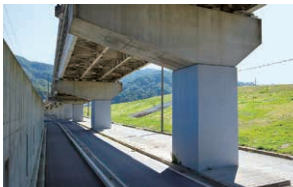
国道45号の高架脚
