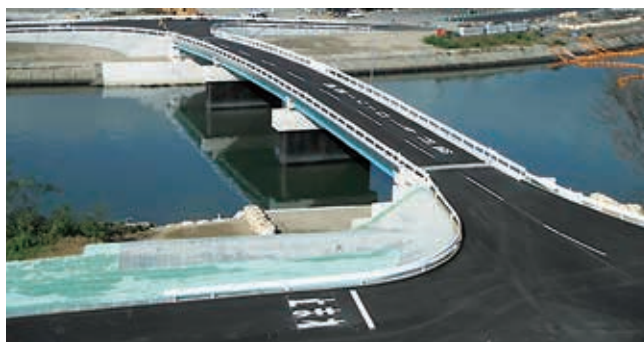
JXTG エネルギー(株)仙台製油所サンブリッジ（宮城県多賀城市）
