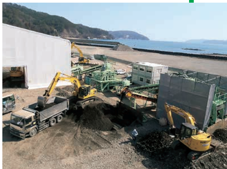
カルスピン®工法を活用した再生処理の全景 (釜石市災害廃棄物処理事業)
