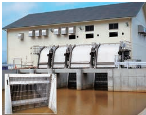
高砂南部排水機場除塵設備（宮城県仙台市）
