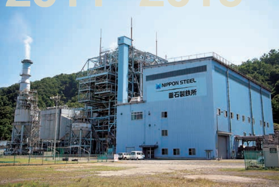
釜石製鉄所エネルギー工場
