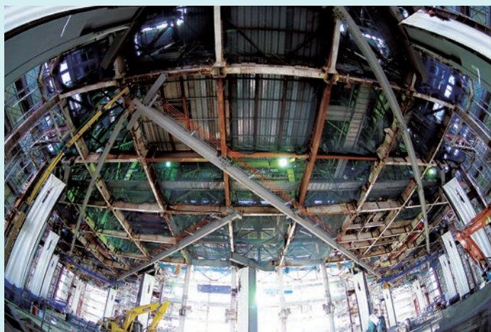
工場のように作業が進む解体現場
