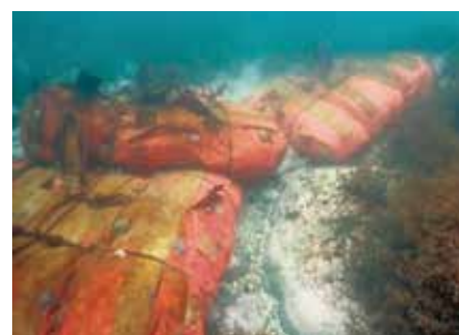
② 大型土のうタイプ(ビバリーユニット) 腐植酸鉄供給ユニットを透水性の袋に詰め、静穏海域に沈設。
