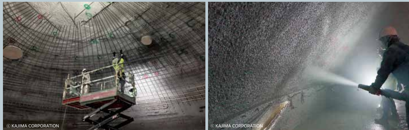
配筋(左)とCUCO®-SUICOMショット吹付け(右)の様子
