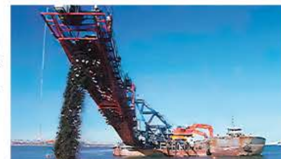
東京国際空港(羽田空港)新滑走路の埋立工事 (東京都大田区)
