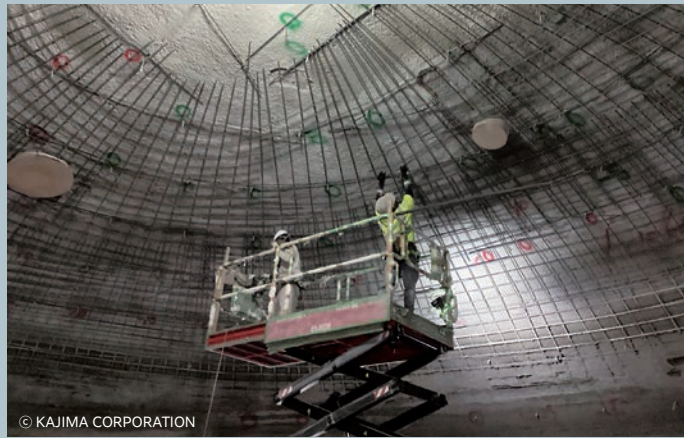
配筋(左)とCUCO®-SUICOMショット吹付け(右)の様子
