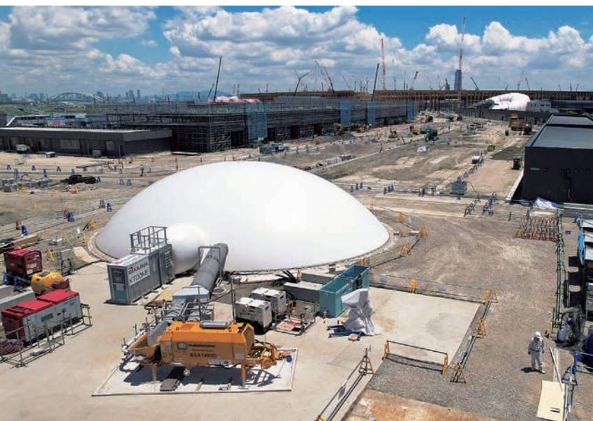
大阪・関西万博CUCO®-SUICOM ドーム施工状況（2024年6月撮影） © KAJIMA CORPORATION
