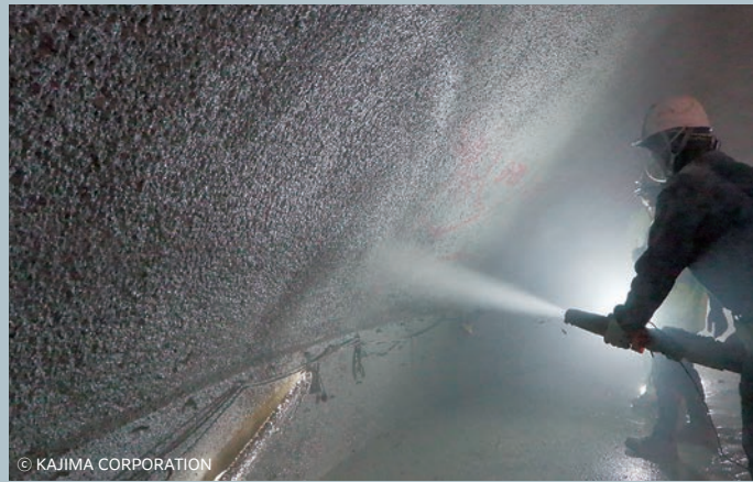
配筋(左)とCUCO®-SUICOMショット吹付け(右)の様子
