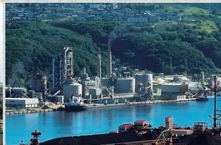
日鉄セメント(株)本社・工場 (北海道室蘭市)
