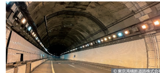
東京湾アクアライン (千葉県木更津市・神奈川県川崎市)
