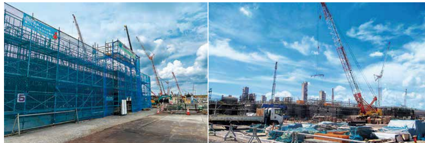
建設中の名古屋製鉄所 新熱延工場
