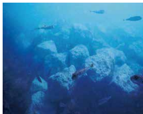
ビバリー® ロックの設置作業風景
