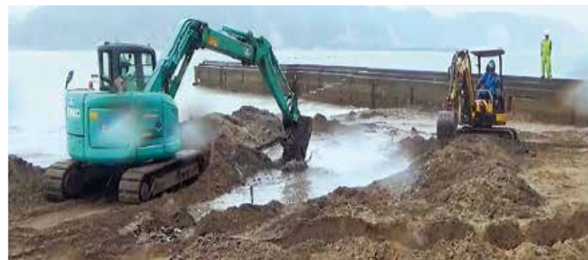
ビバリー® バッグを砂浜に埋設
