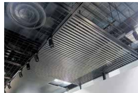
天井ルーバー
