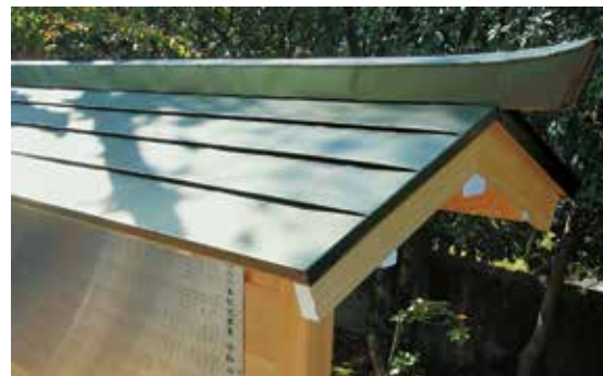
亀山神社の屋根付き奉名板(広島県呉市)
