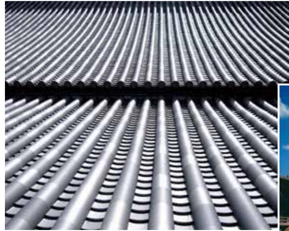
増上寺大殿屋根瓦全体と全景(東京都港区)
