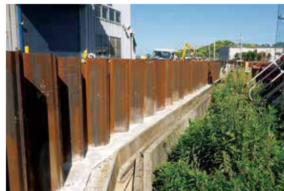
浸水対策用鋼製遮水壁の施工中(左)と施工後(右)
