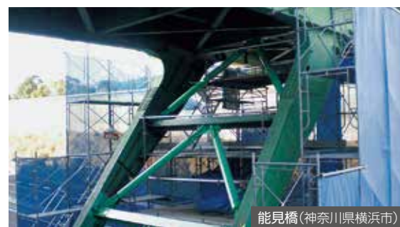
能見橋(神奈川県横浜市)
