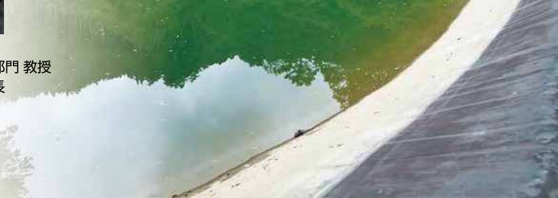
三山池 (高知県長岡郡本山町) 高知県内に点在する220カ所(2022年7月末時点)の防災重点農業用ため池 ※2 の1つ。高知大学と日本製鉄が共同開発した鋼矢板二重式工法によるため池堤体の補強技術 ※3 が採用されました。
