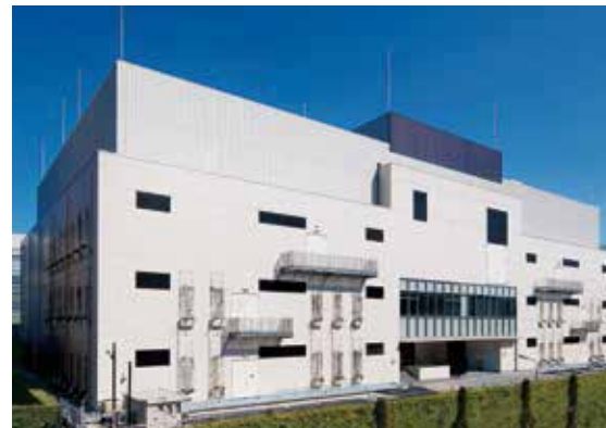
日鉄ソリューションズ(株)第5データセンター (東京都三鷹市)
