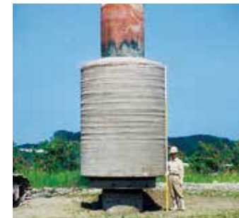
拡大根固め部
