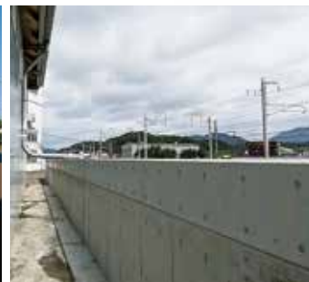
鋼矢板施工後
