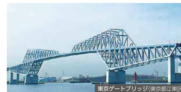
東京ゲートブリッジ(東京都江東区)
