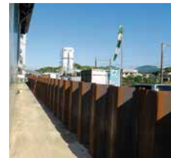
鋼矢板施工中
