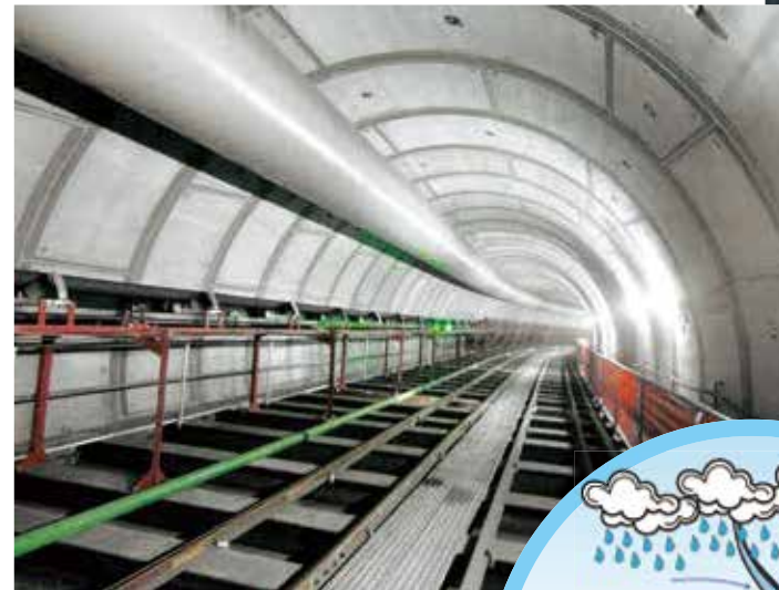
古川地下調節池
