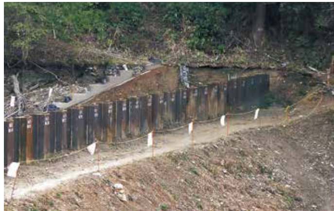
三山池での施工風景
