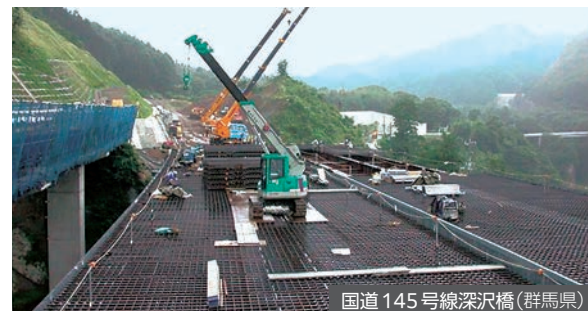
国道145号線深沢橋(群馬県)
