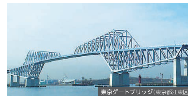
東京ゲートブリッジ(東京都江東区)
