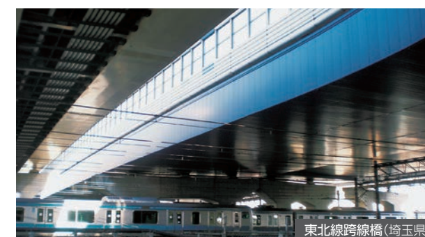
東北線跨線橋(埼玉県)
