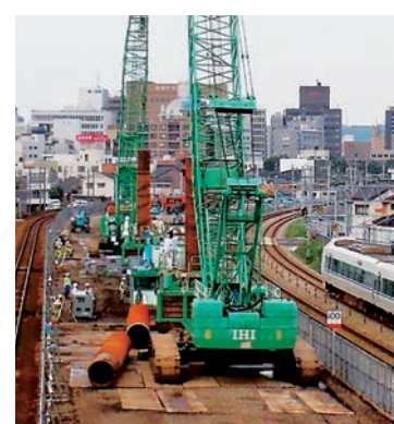
施工状況(全周回転式杭打機) 提供: 鉄道・運輸機構
