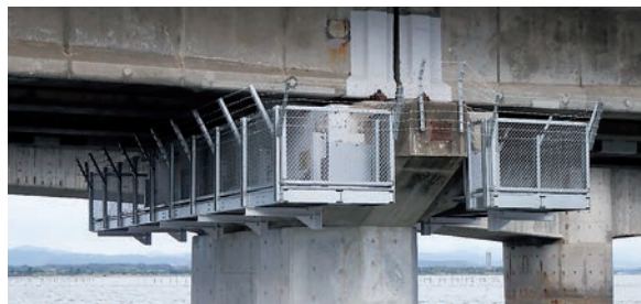
東海道新幹線/浜名橋梁下部工検査路(ZAM®製)
