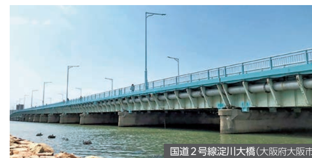
国道2号線淀川大橋(大阪府大阪市)
