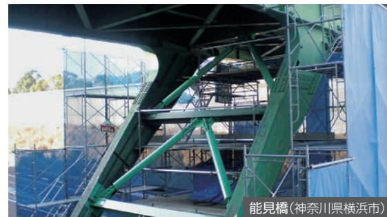
能見橋(神奈川県横浜市)
