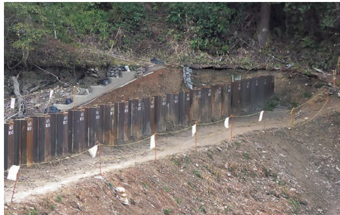
三山池での施工風景
