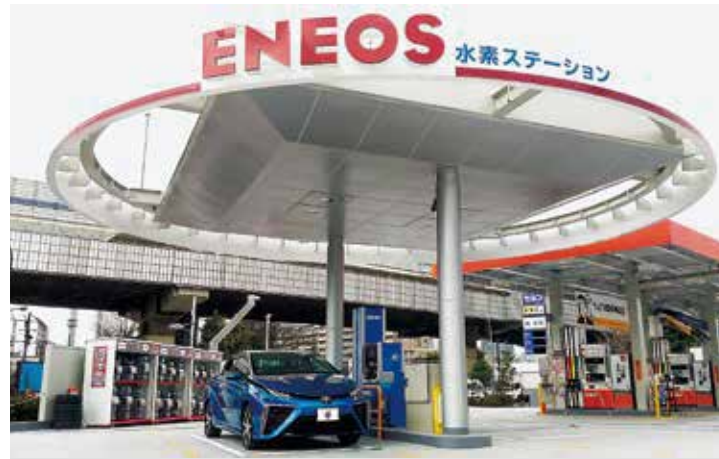
ENEOS(株) Dr.Drive 潮見公園水素ステーション(東京都江東区) 東京都内初のサービス・ステーション(SS)併設型水素ステーションです。
