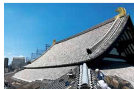
増上寺大殿屋根工事全景
