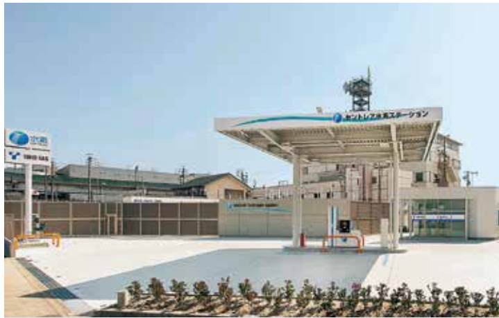
東邦ガス(株)セントレア水素ステーション(愛知県常滑市) 中部国際空港に隣接する燃料電池バス対応の水素ステーション。 水素は都市ガスを原料に水素ステーションで製造するオンサイト型です。
