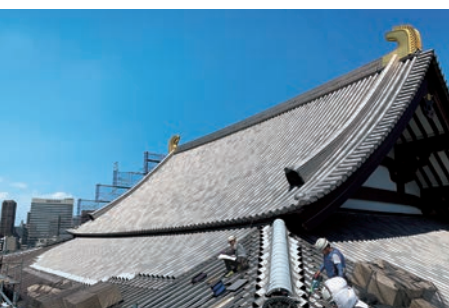
増上寺大殿屋根工事全景
