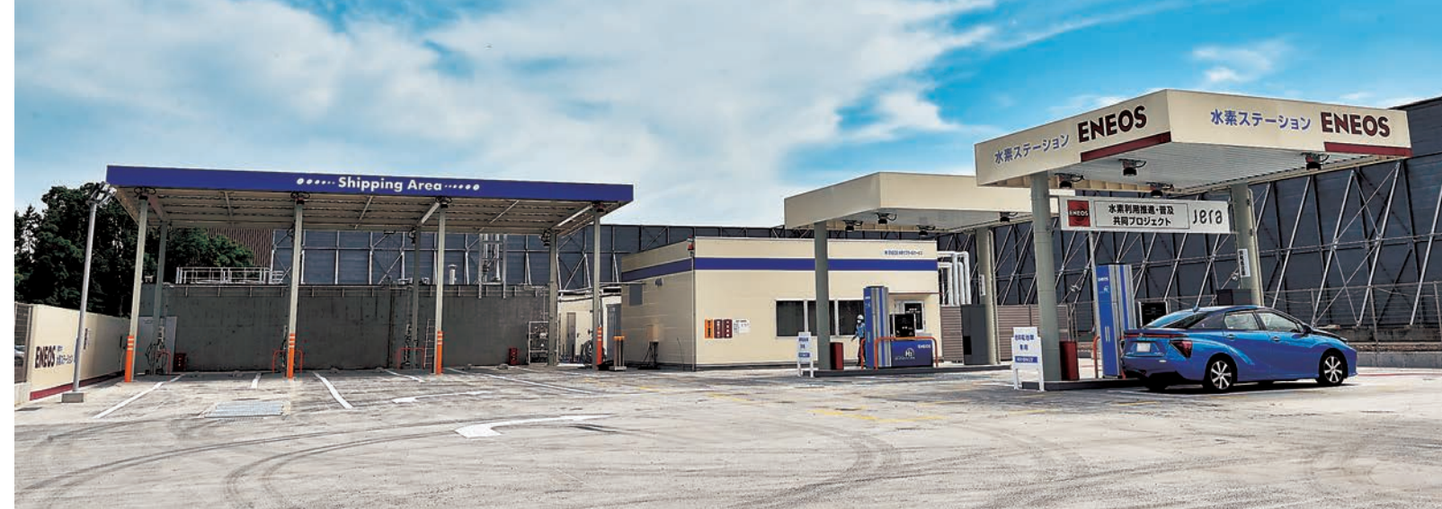
しかおい水素ファーム ® (北海道鹿追町) 家畜(牛)ふん尿由来の再生可能エネルギーの水素を活用した北海道初の定置式水素ステーションです。
