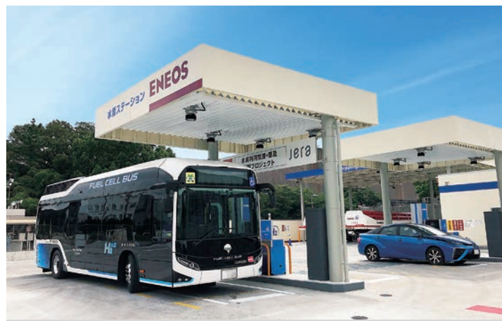
ENEOS(株) 東京大井水素ステーション(東京都品川区) オンサイト型で主要設備は2系統を持ち、供給能力は国内最大級。燃料電池車、燃料電池バスに加え、他の水素ステーション向け水素トレーラーや移動式水素ステーションへの水素供給を行っています。
