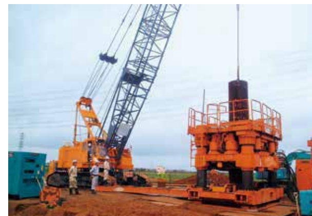
NSエコパイル®による送電線鉄塔の基礎工事状況
