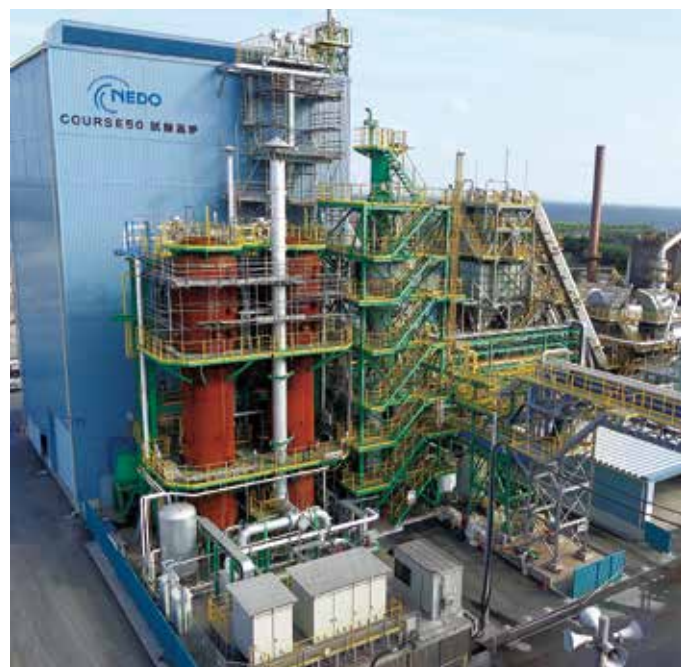
COURSE50試験高炉外観(日本製鉄 東日本製鉄所 君津地区) NEDO・日本鉄鋼連盟：COURSE50
