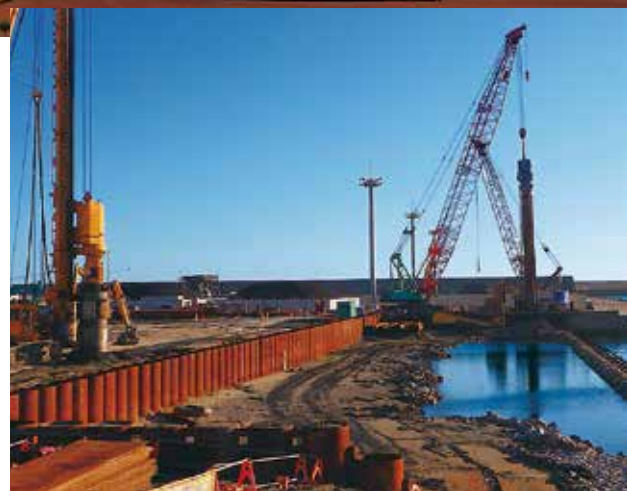
鋼管矢板による港湾護岸の施工状況
