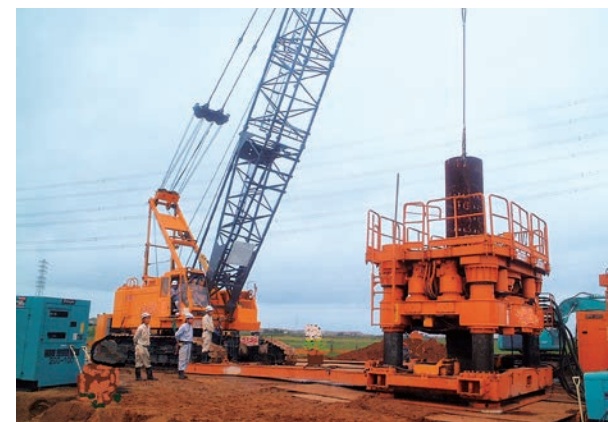
NSエコパイル®による送電線鉄塔の基礎工事状況 写真提供：東洋テクノ(株)
