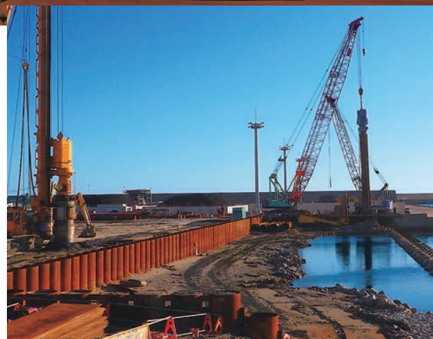
鋼管矢板による港湾護岸の施工状況 写真提供：東洋・本間特定建設工事共同企業体
