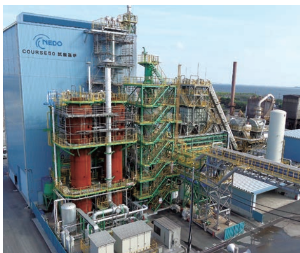
COURSE50試験高炉外観 NEDO・日本鉄鋼連盟：COURSE50
