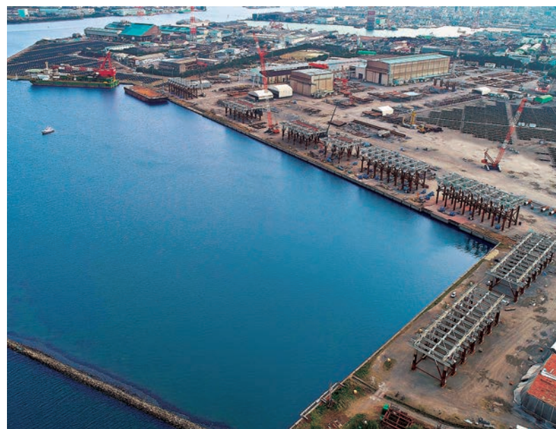
広大な製作ヤード
