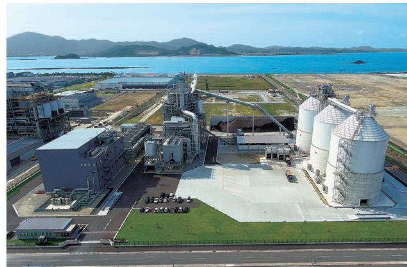
国内最大級の発電量を誇る荻田バイオマス発電所(福岡県荻田町)
