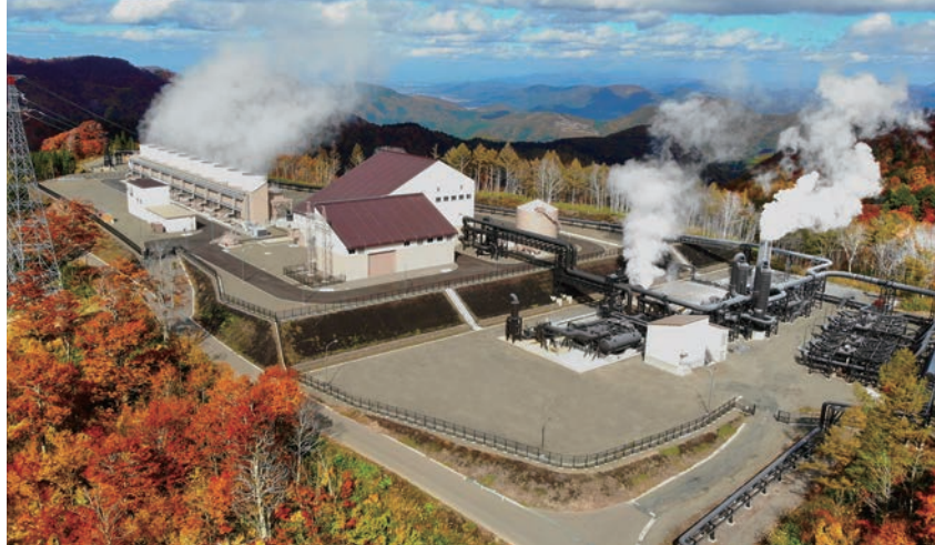
山葵沢地熱発電所 (秋田県湯沢市)
