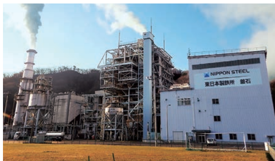
日本製鉄 東日本製鉄所 釜石地区 (岩手県釜石市) の発電施設
