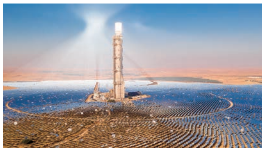
タワー式集光型太陽熱発電（CSP=Concentrating Solar Power）
