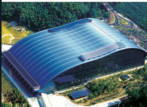
長尺屋根の施工例 (九州国立博物館)
