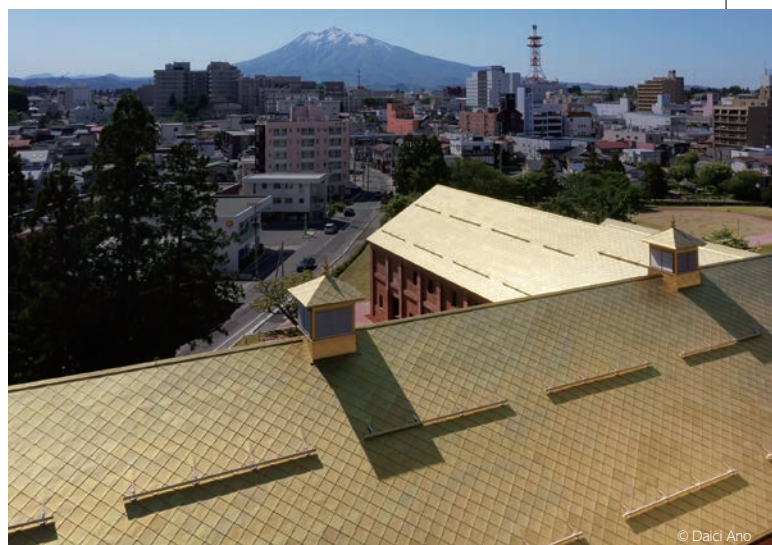
屋根材にシードル・ゴールドに輝く日本製鉄のTranTixxiiが採用された。
