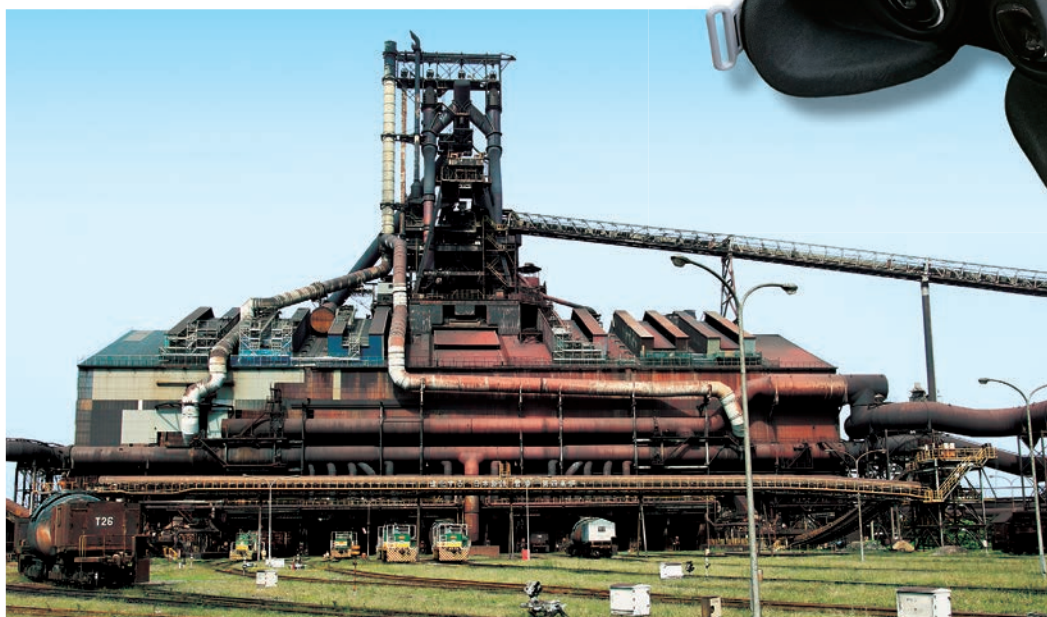
東日本製鉄所君津地区第4高炉 高炉には1000点以上のセンサーが設置されています。
