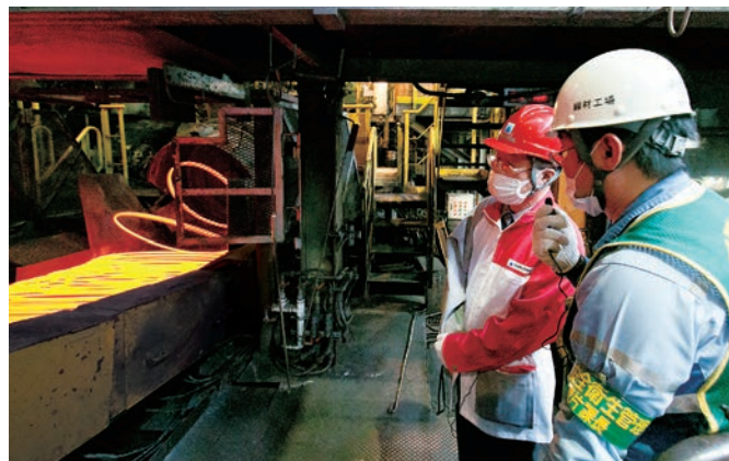
線材熱延工程
