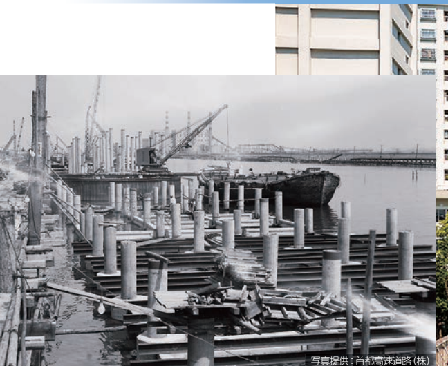
首都高速1号羽田線の建設当時 用地買収の時間が十分になかったため、 家屋の密集地を避け、公共空間の京浜 運河で工事が進められた。
