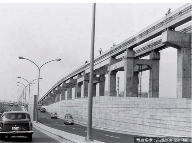
首都高速1号羽田線の建設当時 用地買収の時間が十分になかったため、 家屋の密集地を避け、公共空間の京浜 運河で工事が進められた。
