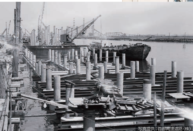
首都高速1号羽田線の建設当時 用地買収の時間が十分になかったため、 家屋の密集地を避け、公共空間の京浜 運河で工事が進められた。
