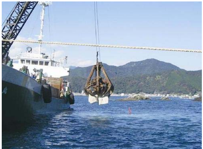
人工漁礁ブロックを海中に投入していく様子
