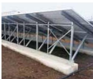
太陽光発電設備用架台使用例
