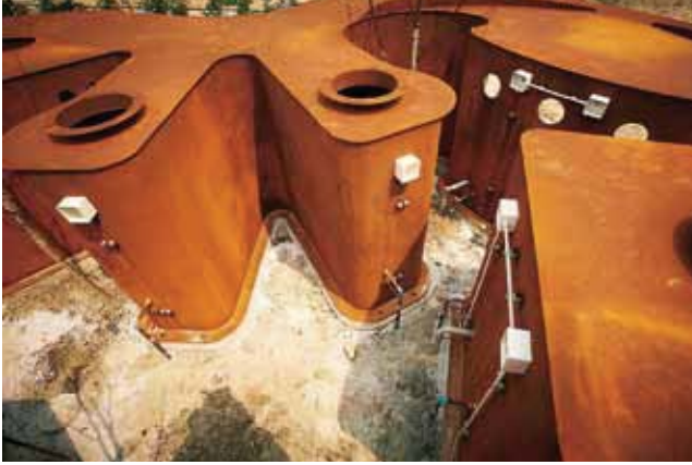
北九州市の公園に建設中の公衆トイレ
