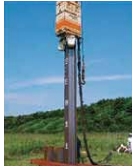
鋼矢板の打設
