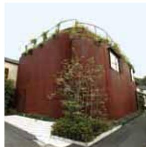
新日鉄の「コルテン鋼<sup>※1</sup>」の素材感や性能を存分に活かした全溶接住宅が、平成23年度大谷美術館賞<sup>※2</sup>を受賞した。都市部の個人住宅を100年以上継続使用する思想のもと設計・施工され、時の経過で風格を増し、30年と言われる日本の住宅寿命の常識を打ち破る試みが評価された。
