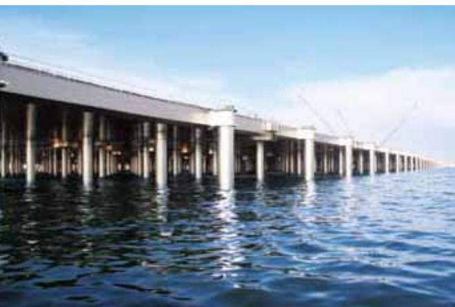
新日鉄エンジニアリング(株)と日鉄トピーブリッジ(株)は、JFEエンジニアリング(株)と共同で海上の厳しい腐食環境にさらされるジャケット式栈橋の期待耐用年数を100年とする防食工法技術を開発。羽田空港D滑走路栈橋では従来工法に比べ初期投資額を同等に抑えながら、100年間のライフサイクルコストを80%低減することに成功。
